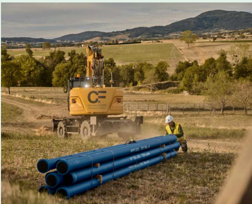
Irriguer Création de réseaux sous pression pour l'irrigation.
