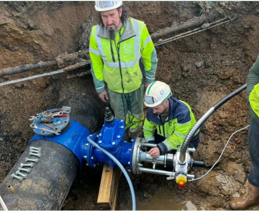
Prise en charge en eau, gros diamètre Raccordement sur conduite en service, sans coupure.
