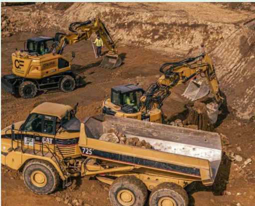
Terrassement et aménagement Plateformes, nivellement, aménagements extérieurs.
