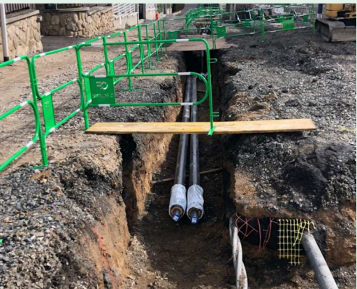
Transporter de l'eau chaude Réseaux de chaleur.
